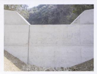
・チサンコート使用後のコンクリート面 (公共工事の検査に合格する仕上がり になっております)
